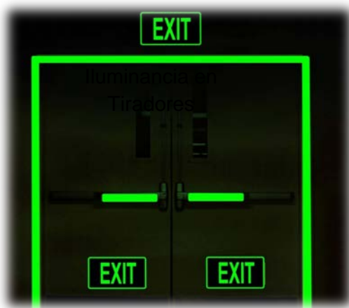
Iluminancia fluorescente en marco de puerta y en los tiradores de apertura.
